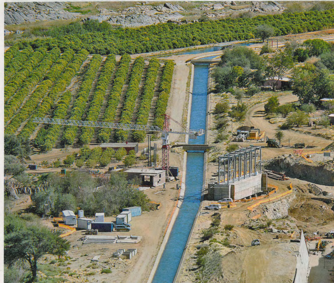
Die kanaal wat water aan die boerderygemeenskap lewer, is behou met die bou van die Neusberg-kragsentrale. Die nuwe kragstasie se water gaan terug in die rivier. Foto: VERSKAF
