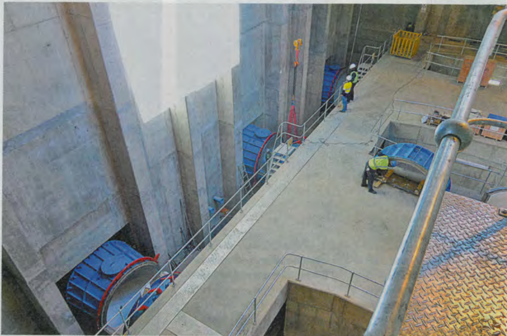
Wanneer die Neusberg-projek afgehandel is, sal die water van die Oranjerivier deur hierdie turbines vloei om krag op te wek tot voordeel van nabygeleë Kakamas.
